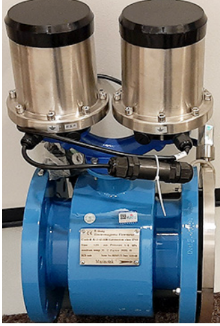
Magneettis-induktiivinen virtausmittari (DN125), johon integroitu myös painemittari.
